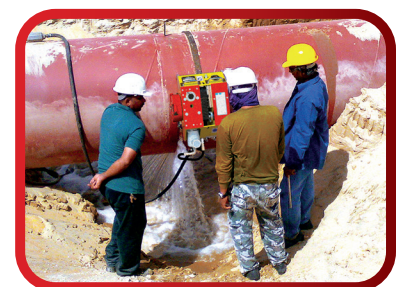
可通过增加延长链条来适应不同管径
