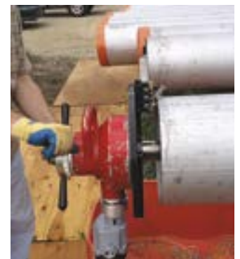
SDB 进行管端加工
